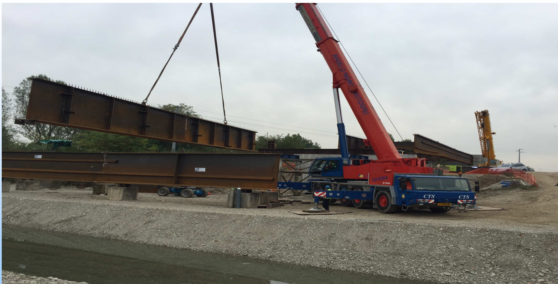
SOLLEVAMENTO A TRAVATE METALLICHE SUL VALSAMOGGIA
